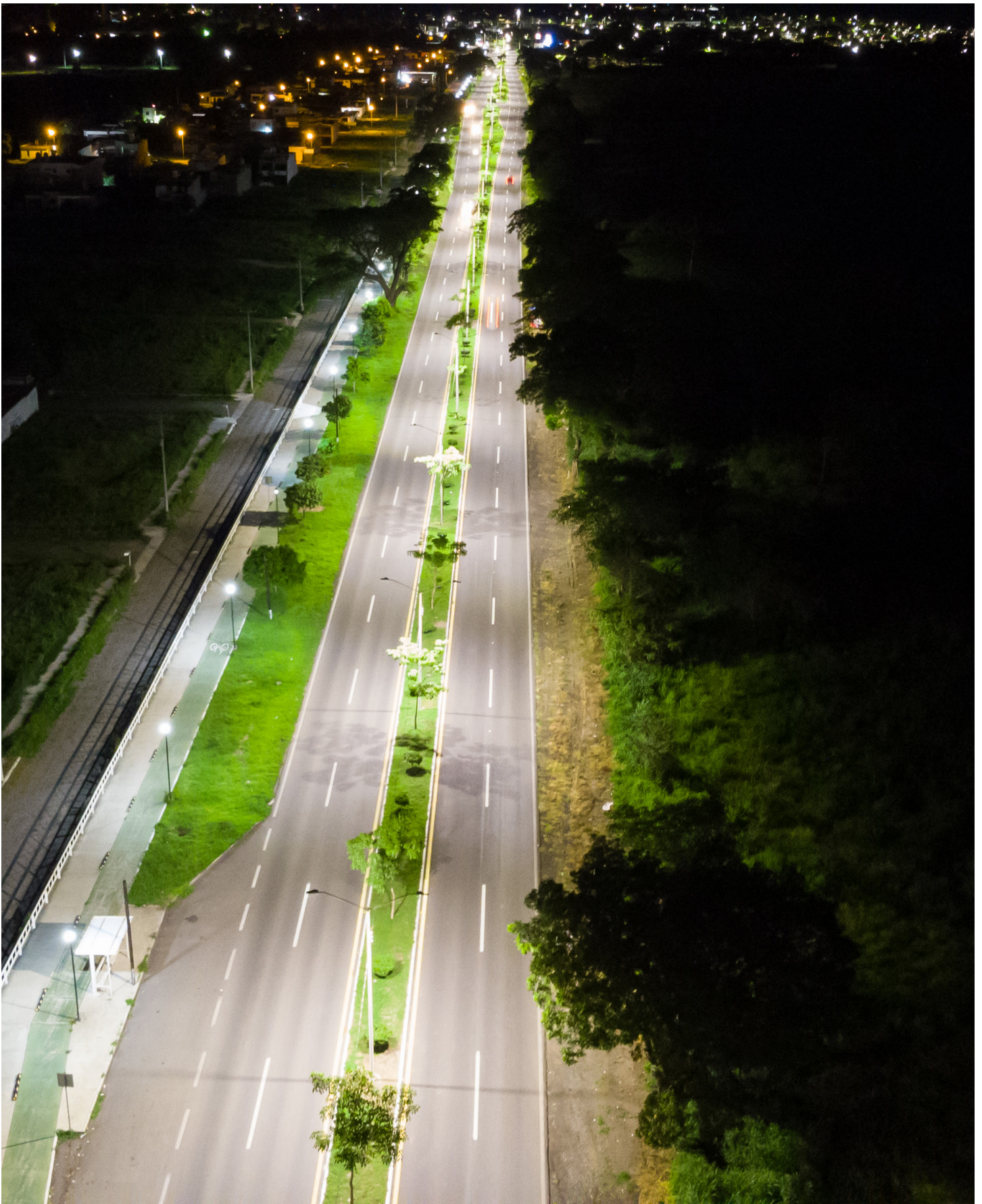
Entrada Coquimatlán iluminado
